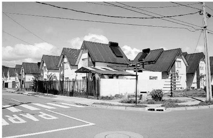
Las paneles fotovoltaicos se instalarán en las viviendas para captar energía solar y con ello reducir el consumo de energía eléctrica obtenida del sistema interconectado central.
