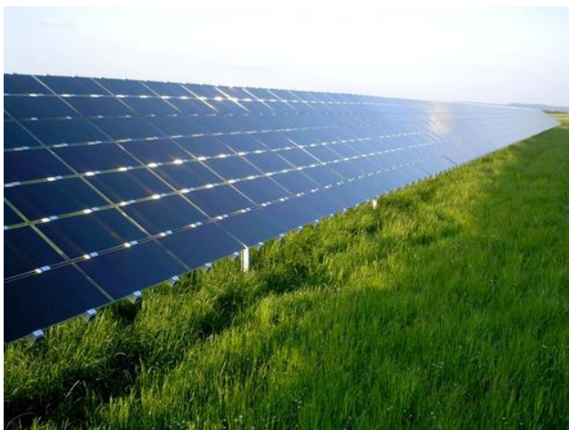
Figura 41: Panel solar fotovoltaico de tipo capa fina
