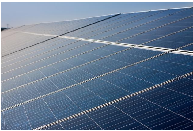
Figura 40: Panel solar fotovoltaico de tipo policristalino
