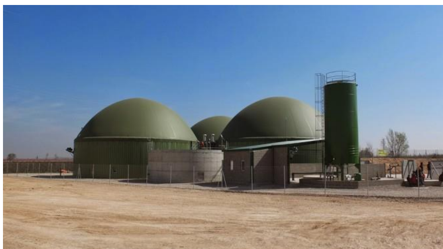
Figura 49: Planta de biogás
