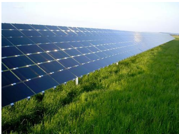
Figura 40: Panel solar fotovoltaico de tipo capa fina
